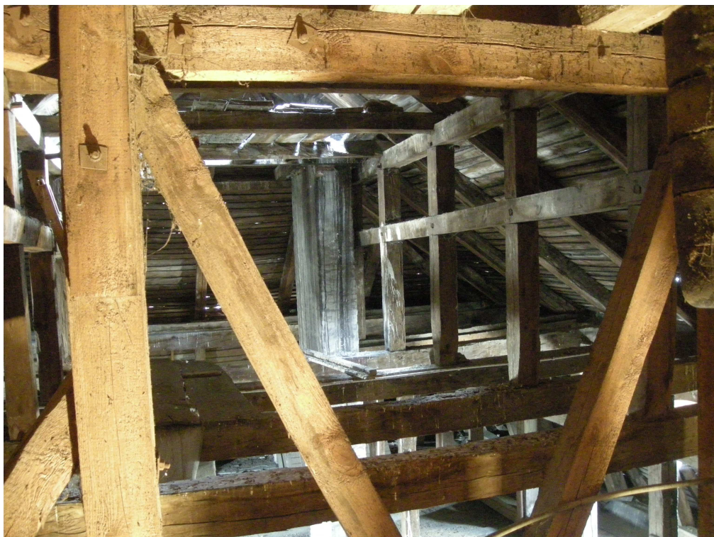
Fot. nr 30. Widok na porażoną owadami krokiew po stronie elewacji frontowej (przeznaczona do wymiany).
