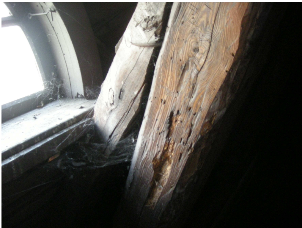
Fot. nr 29. Widok na porażoną owadami krokiew po stronie elewacji frontowej (przeznaczona do wymiany).
