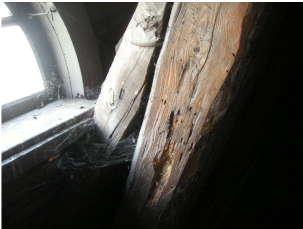
Fot. nr 4. Widok na porażoną owadami krokiew po stronie elewacji frontowej (przeznaczona do wymiany).
