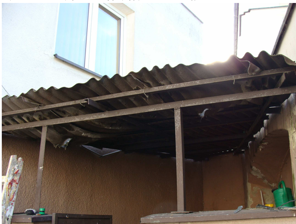
Fot. nr 24. Widok dachu nad śmietnikiem – zakładane odnowienie konstrukcji poprzez oczyszczenie i wymianę pokrycia na blachę trapezową w kolorze szarym wraz z obróbkami bocznymi).
