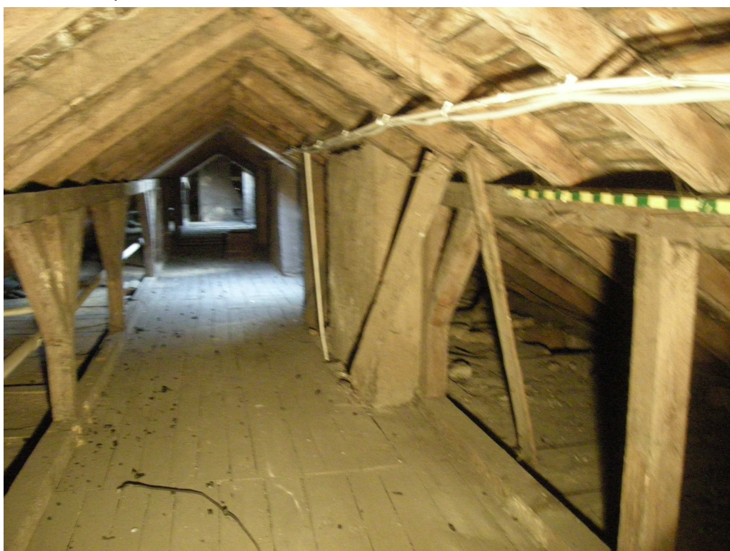
Fot. nr 28. Widok konstrukcji dachu w bryle B budynku. Widoczne miejsce montażu wentylatora oddymiającego nad klatką schodową K2. W tle widoczne kominy do odbudowania (obecnie kominy zakończone są pod połacią dachową).
