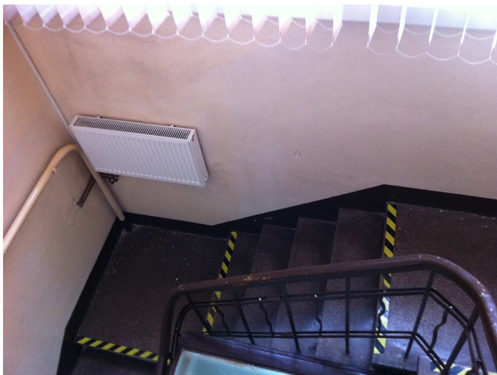
Fot. nr 23. Widok schodów i poręczy w klatce schodowej K2 (grzejnik zmniejszający światło przejścia – do przeniesienia, poręcz schodów do podniesienia do wys. 1,1m – np. poprzez wspawanie odcinków prętów w istniejące pręty pionowe balustrady)
