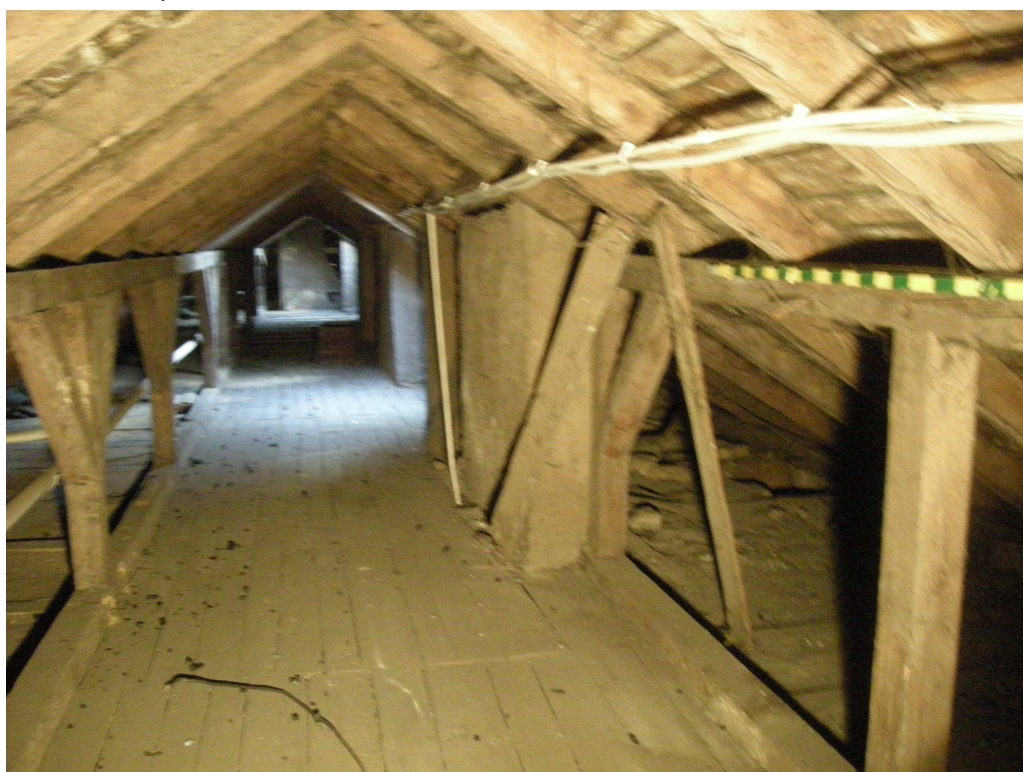
Fot. nr 3. Widok konstrukcji dachu w bryle B budynku. Widoczne miejsce montażu wentylatora oddymiającego nad klatką schodową K2. W tle widoczne kominy do odbudowania (obecnie kominy zakończone są pod połacią dachową).
