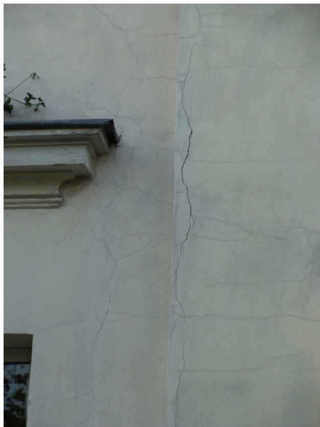
Fot. nr 20 - 21. Widok uszkodzeń tynku na elewacji bocznej (lewej). Widoczne instalacje przeznaczone do ukrycia pod tynkiem.
