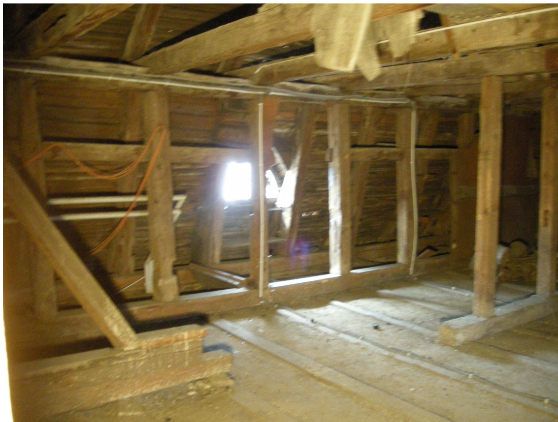
Fot. nr 1. Widok konstrukcji dachu w bryle A budynku. Widoczne pochylenie słupów w kierunku wieży.
