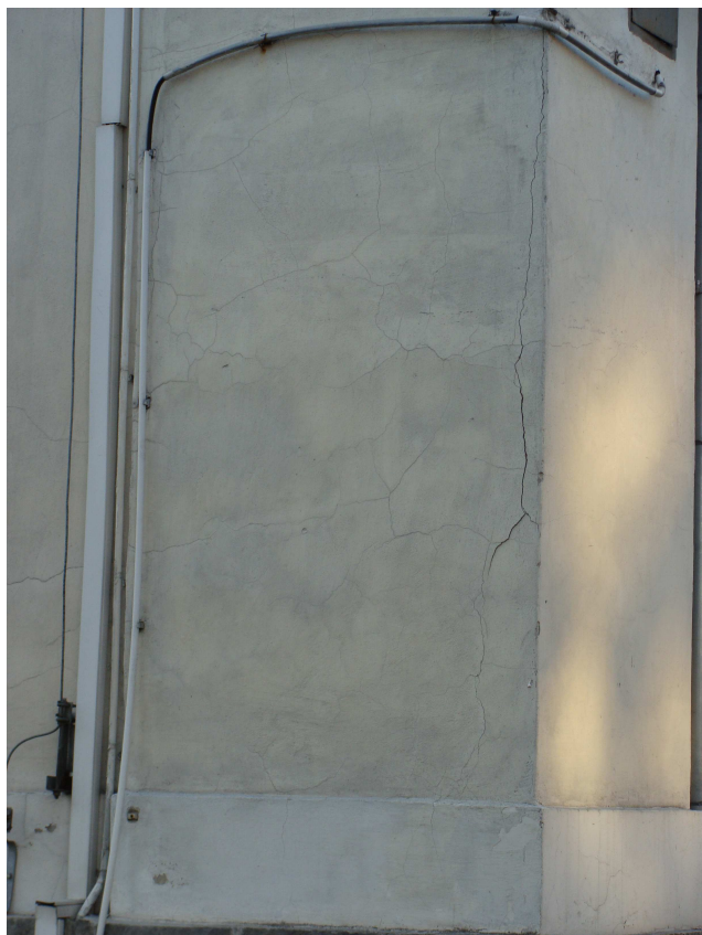
Fot. nr 20 - 21. Widok uszkodzeń tynku na elewacji bocznej (lewej). Widoczne instalacje przeznaczone do ukrycia pod tynkiem.
