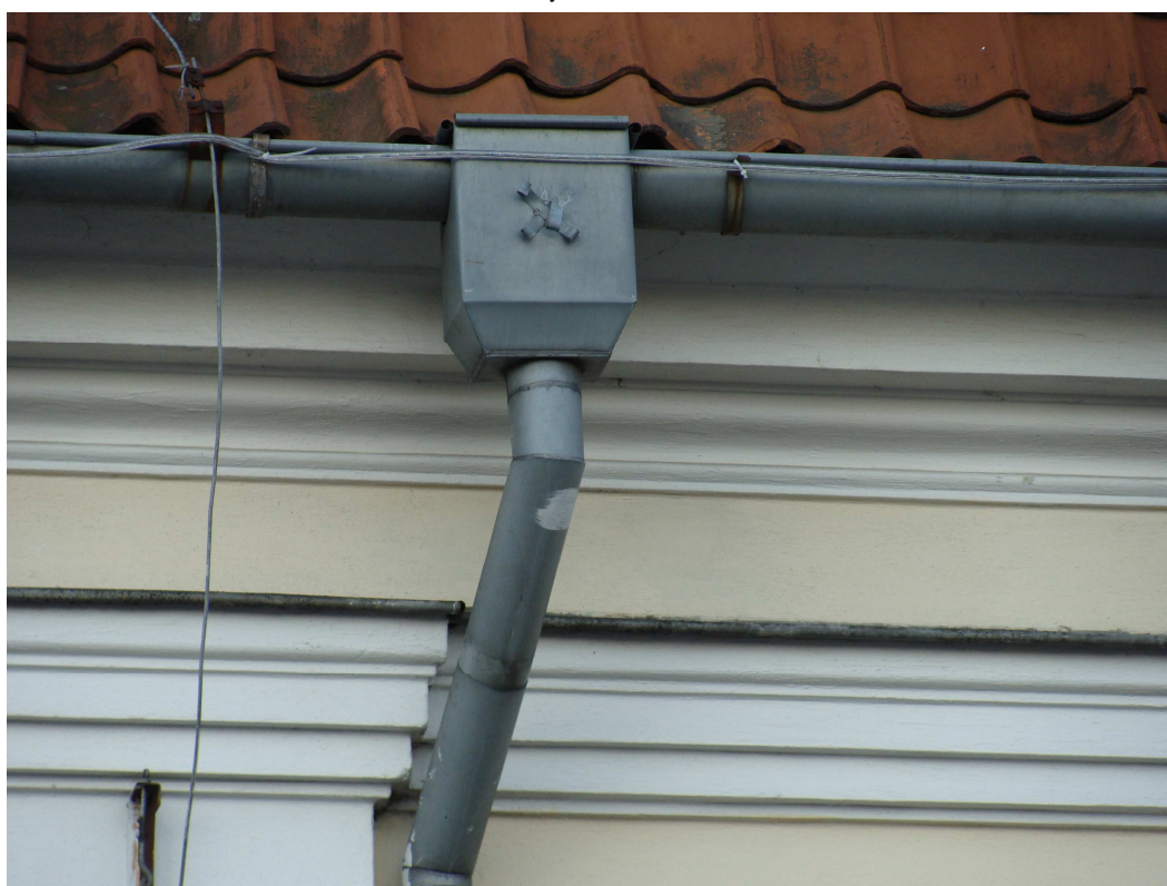
Fot. nr 15. Widok istniejącego oryynnowania – do wymiany na nowe z blachy tytanowo-cynkowej (patynowanej-szarej)
