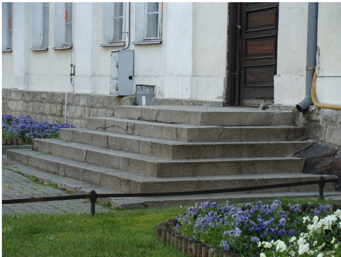
Fot. nr 25. Widok na spękane boczne schody - przeznaczone do odbudowy. Nowa okładzina schodów z płyty granitowej. Widoczny w tle cokół obłożony płytami kamiennymi – przeznaczona okładzina kamienna cokółu do zdemontowania i zastąpienia tynkiem (wg programu prac konserwatorskich).
