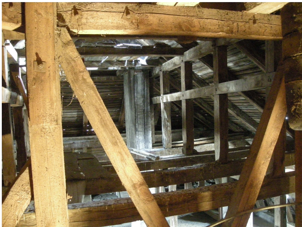
Fot. nr 2. Widok konstrukcji dachu w bryle A budynku (II poziom). Widoczne pochylenie słupów w kierunku wieży.
