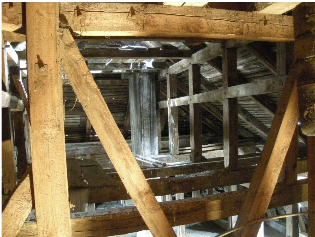
Fot. nr 27. Widok konstrukcji dachu w bryle A budynku (II poziom). Widoczne pochylenie słupów w kierunku wieży.
