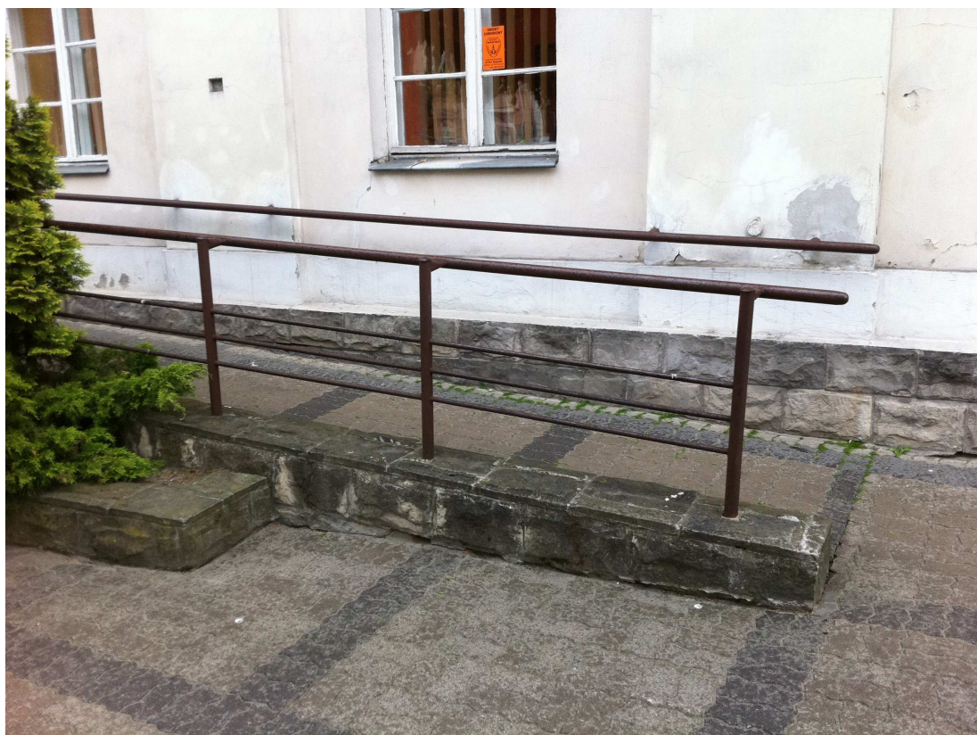
Fot. nr 22. Widok podjazdu dla osób niepełnosprawnych przy wejściu głównym. W tle okładzina kamienna przeznaczona do usunięcia – wg programu prac konserwatorskich
