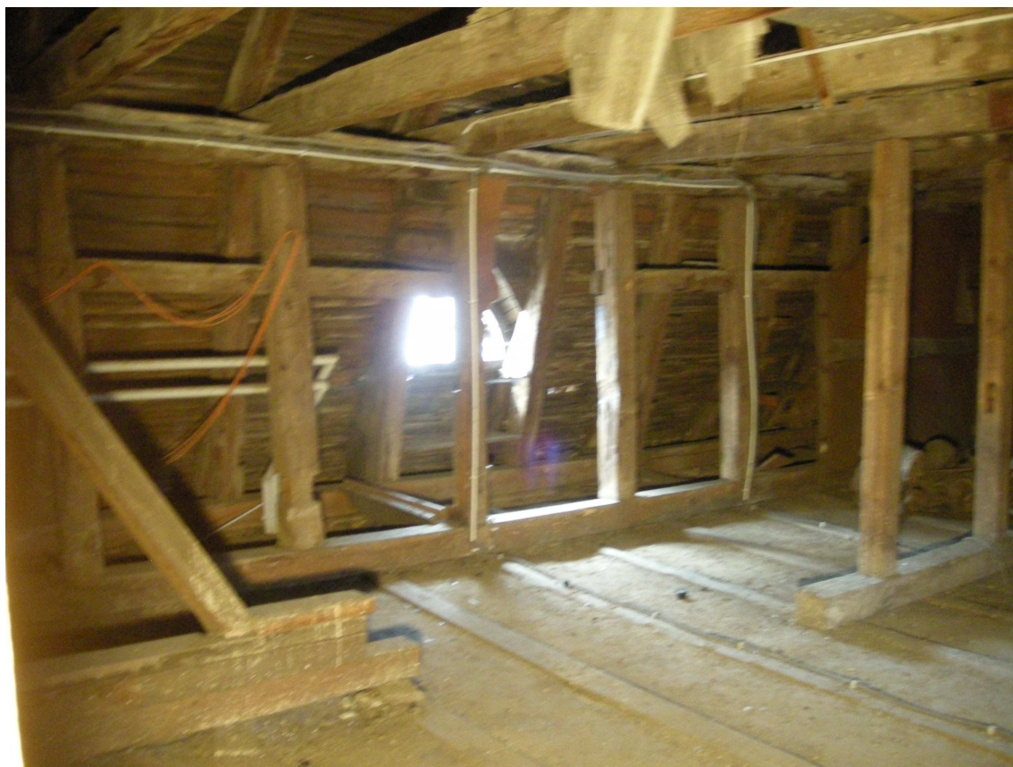
Fot. nr 26. Widok konstrukcji dachu w bryle A budynku. Widoczne pochylenie słupów w kierunku wieży.
