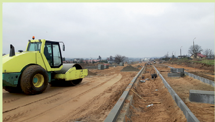
Obecnie w Alei św. Wojciecha są budowane chodniki i ścieżka rowerowa
