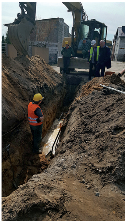
Prace w obszarze A4 chwilowo wstrzymano ze względu na wysoki poziom wód gruntowych
