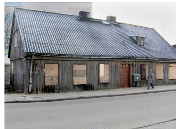
Ulica Płocka przed i po przebudowie
