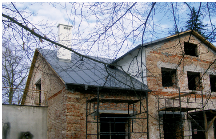
Wre prace przy przebudowie popówki na Pałac Ślubów
