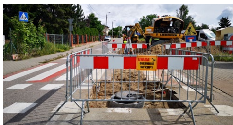
Ruszyły prace na ul. Studzieniec
