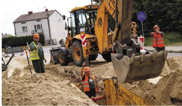
Trwają prace przy ul. Nowej
