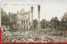
Ruiny hotelu „Zum Forsten Bismarck” w Iławie w Prusach Wschodnich
