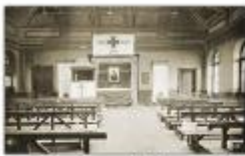
Poczekalnia na dworcu kolejowym w Mławie przekształcona podczas I wojny światowej na kaplicę dla żołnierzy niemieckich. Ambona została umieszczona w klaszku
