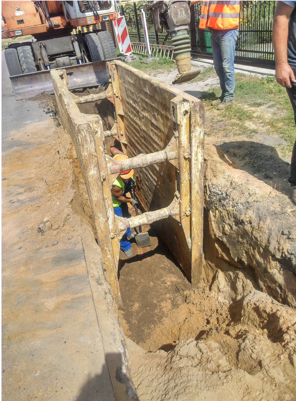
Roboty budowlane w ulicy Wiśniowej
