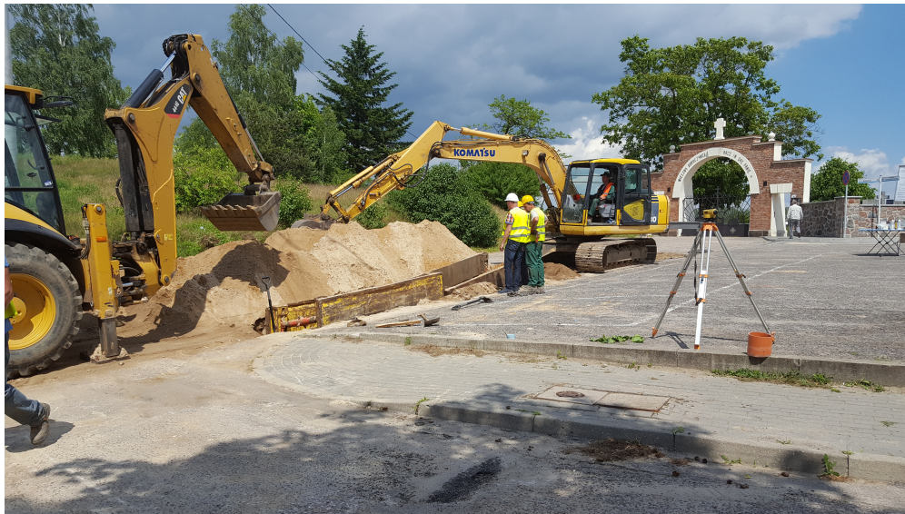
Roboty budowlane w ulicy Cmentarnej
