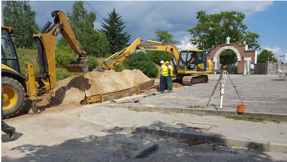
Roboty budowlane w ulicy Cmentarnej
